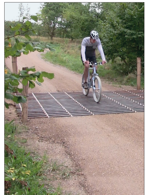
Het hier getoonde veerooster heeft verzinkte buizen
