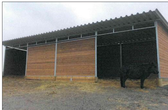
Vorderwand für Weidehütte
