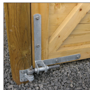
De kraftiga, varmgalvaniserade beslagen kan justeras i alla dimensioner.
