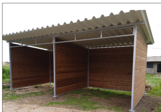
Skillevæg monteret i læskur
