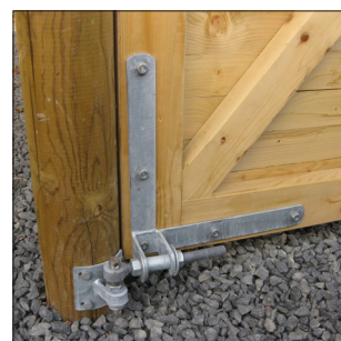
De kraftige varmgalvaniserte beslagene kan justeres i alle dimensjoner.
