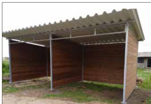
Skiljevägg monterad i Vindskydd
