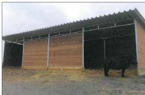
Frontväggar monterad i Vindskydd
